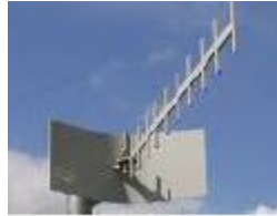
Figura 1. 22. Antena Yagi.
