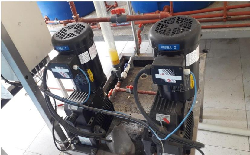
*Conexión de bombas turbidímetro*
