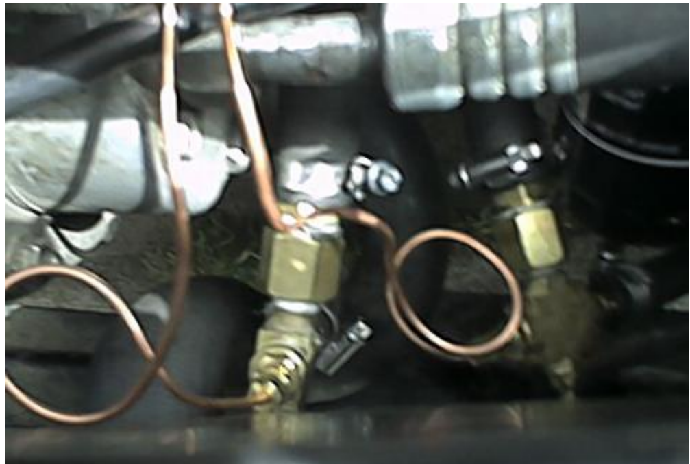
Figura 4. 3 Vista de la instalación de los sensores en las cañerías de ingreso al intercambiador
