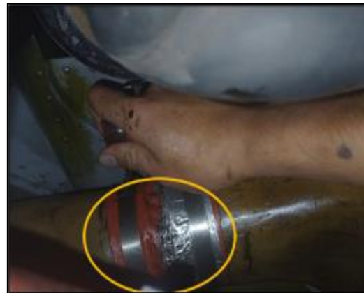
Desconexión de los tubos de ventilación
