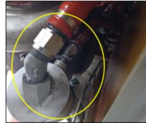
Desconexión de los conductos de aceite
