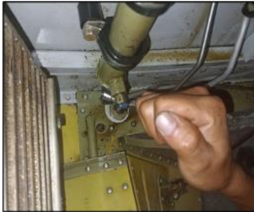
Desconexión de las líneas de drenaje
