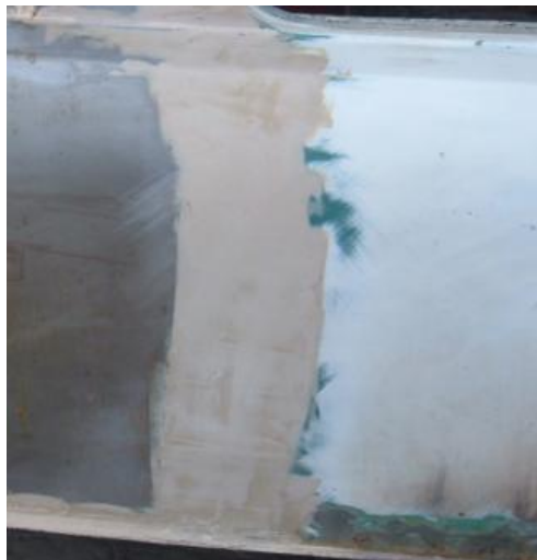
Figura 5.3 Aplicación de la masilla en un panel
