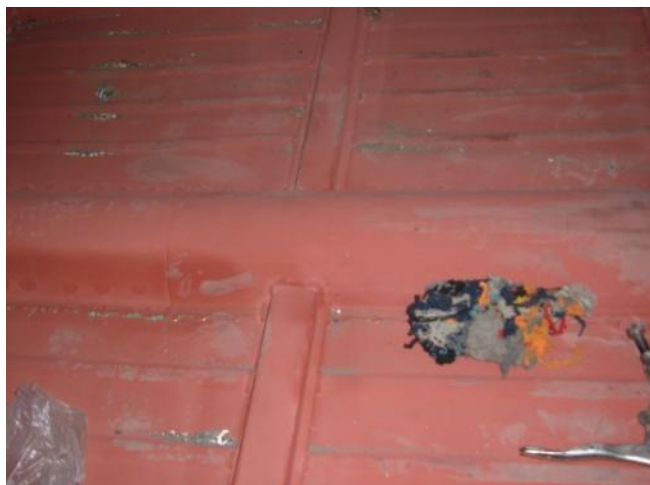
Figura 4.30.- anticorrosivo interno piso
