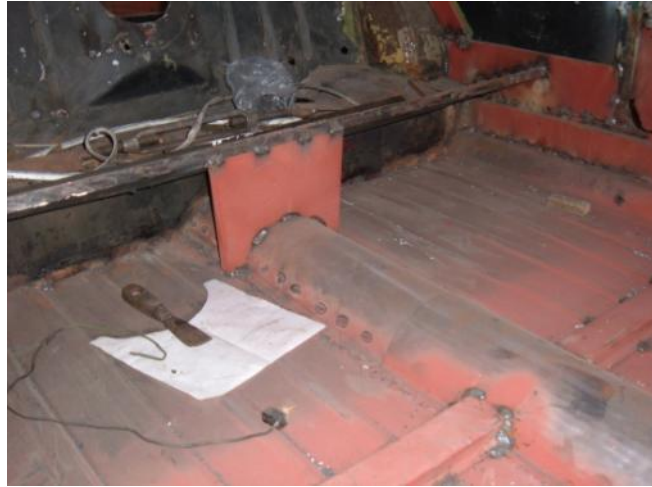
Figura 4.27.- soldadura puente del piso
