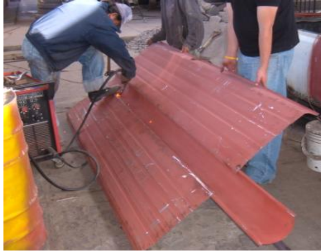
Figura 4.23.- anticorrosivo en nuevo piso
