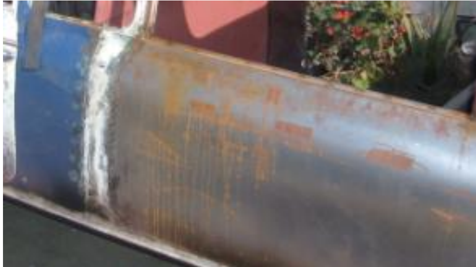
Figura. 5.8 Parte lateral antes del proceso de chapistería.
