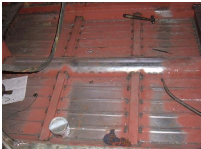
Figura 4.26.- soldadura del piso
