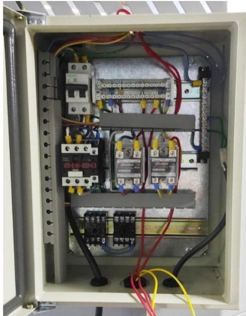
Luego de realizar las conexiones que desempeñan efectivamente la secuencia de control el resto del cableado que ingresa al cajetín se sujetó con varias amarras plásticas, como se visualiza en la Figura 97 con el circuito puesto en marcha.
