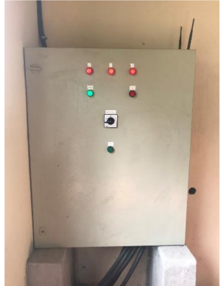
Indicadores Tablero Eléctrico CPP-ESPE Fuente: (Poquiza Yumbolema, 2016)
