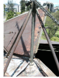
Techo del domo
