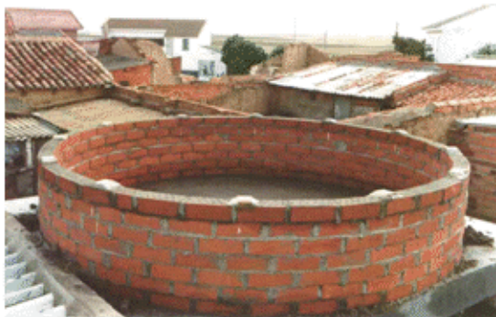
Fig. 1.11: Detalle de la construcción del cimiento en un observatorio astronómico a instalarse en un domicilio, a partir de una pared circular de ladrillos
