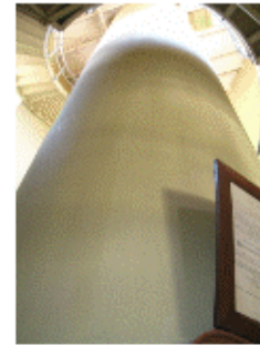
Base de concreto del observatorio
