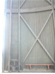
Escalera hacia techo
