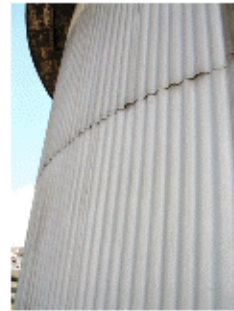
Láminas de zinc de las paredes
