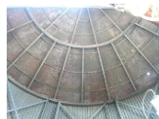
Rieles que conforman el techo
