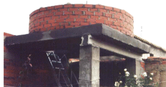
Fig. 1.11: Detalle de la construcción del cimiento en un observatorio astronómico a instalarse en un domicilio, a partir de una pared circular de ladrillos
