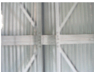
Uniones entre crucetas metálicas en paredes
