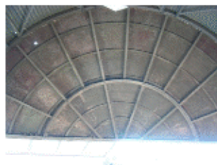
Rieles en estructura que conforman el techo
