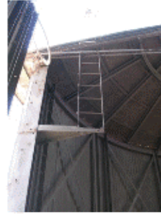
Escalera hacia techo
