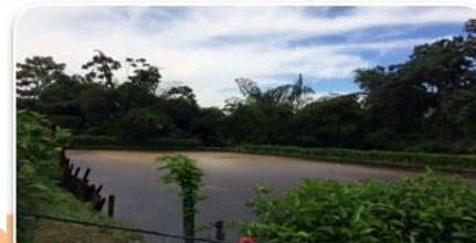
Acondicionamiento del efluente • Laguna de enfriamiento
