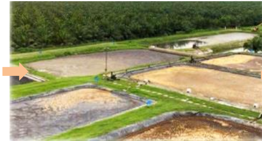
Sistema de Tratamiento Biológico
