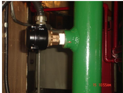
Figura 2.1. Detector de flujo tipo Veleta
