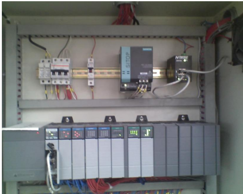
Fig. 3.11 Switch de red Ethernet N-TROM (parte superior derecha).
