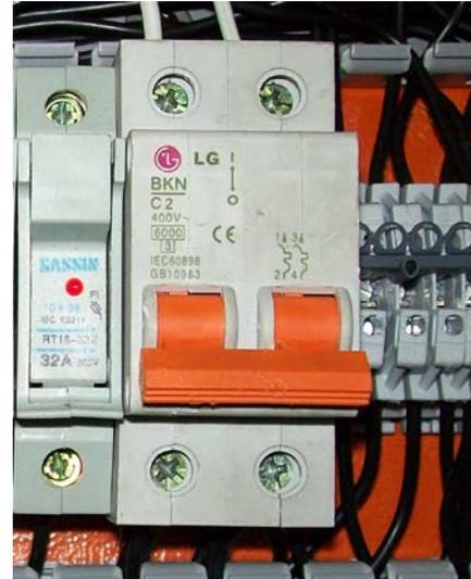
Figura 2.38. Interruptor termomagnético LG.
