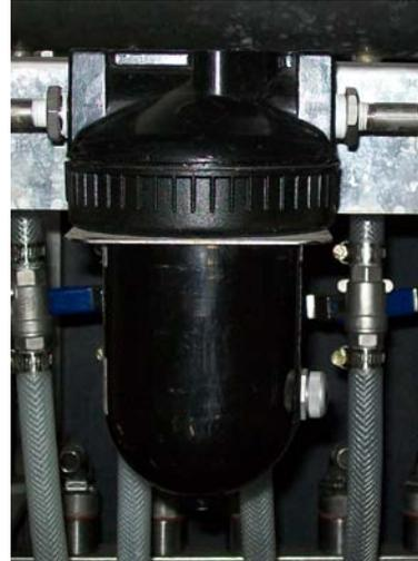
Figura 2.22. Secador de aire.
