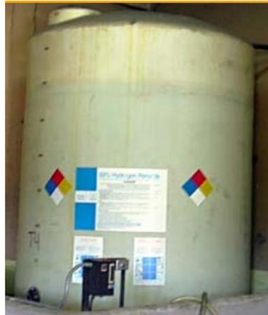
**Figura 1.8. Tanque cilíndrico vertical con techo fijo.**
