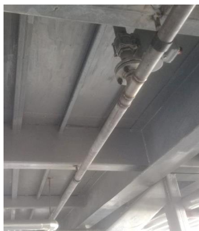
(a) Descarga de tanque TP-31.
