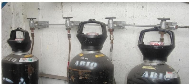
Fig. 3.9: Sistema Centralizado de cilindros de gas argón
