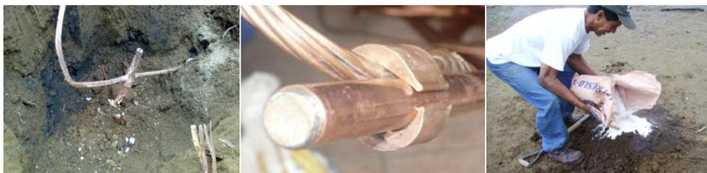
Fig.1.4: Instalación del electrodo a tierra.
