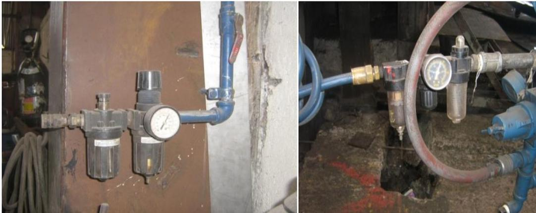
Fig. 3.2: Combinación de filtro, regulador de presión y lubricador en los puntos de utilización.
