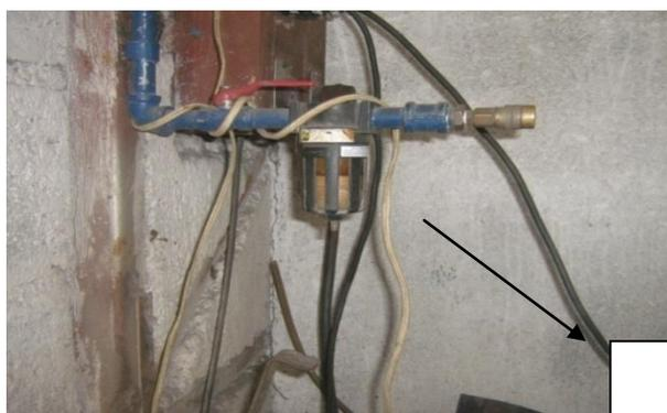
Conductor eléctrico sujeto en la tubería de aire
