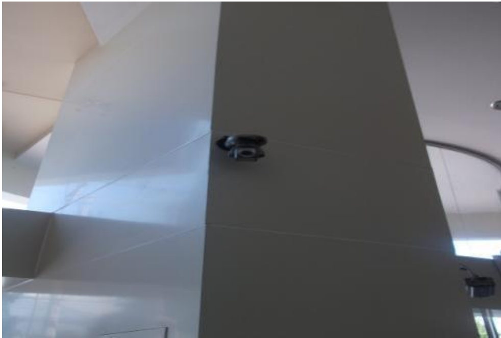
Figura 3.55 Ubicación de las cámaras de seguridad:
