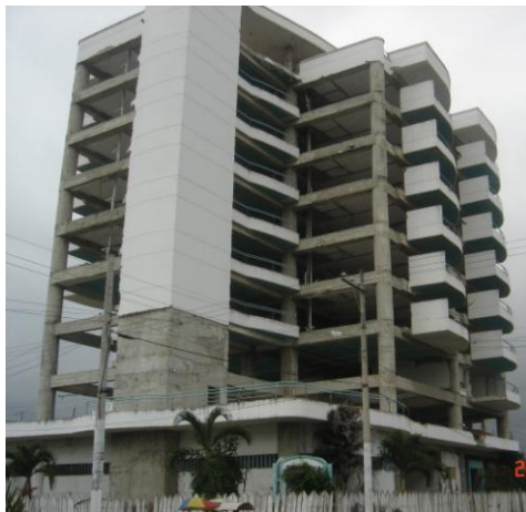
Figura 3 Edificio Mendoza en 2009 con columnas que no colapsaron en la cubierta.
