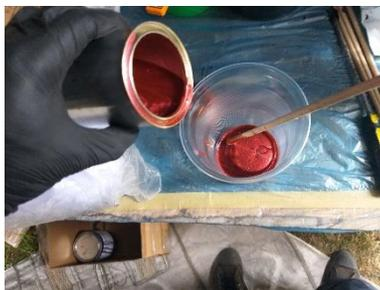
*Nota.* Proceso de mezcla de base color con un 20% de disolvente.
