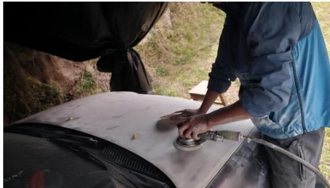
*Nota.* El proceso de lijado a máquina tiene que ser el apoyo de la lija al panel de forma uniforme en relación a sus caras.
