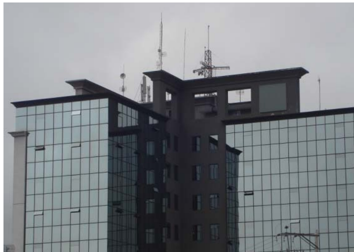
Figura.5.2.Edificio Condominios Banco la Previsora
