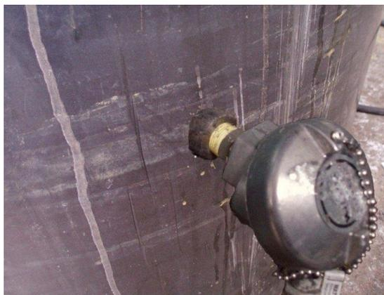
**Figura 4.12** Montaje de RTD en Tanque
