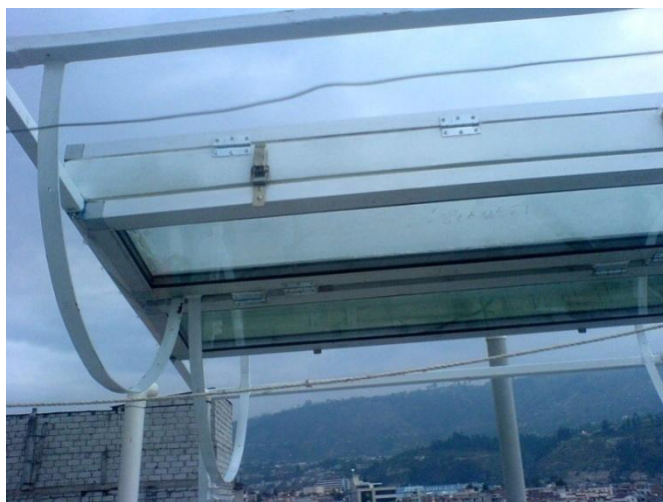
Fotografía 16: Soportes de reflectores.
