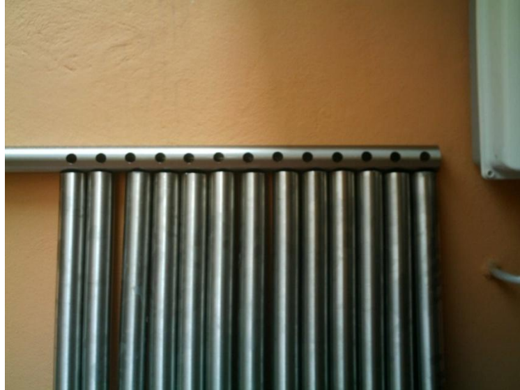
Fotografía 2: Tubos del adsorbedor/colector solar con el distribuidor.
