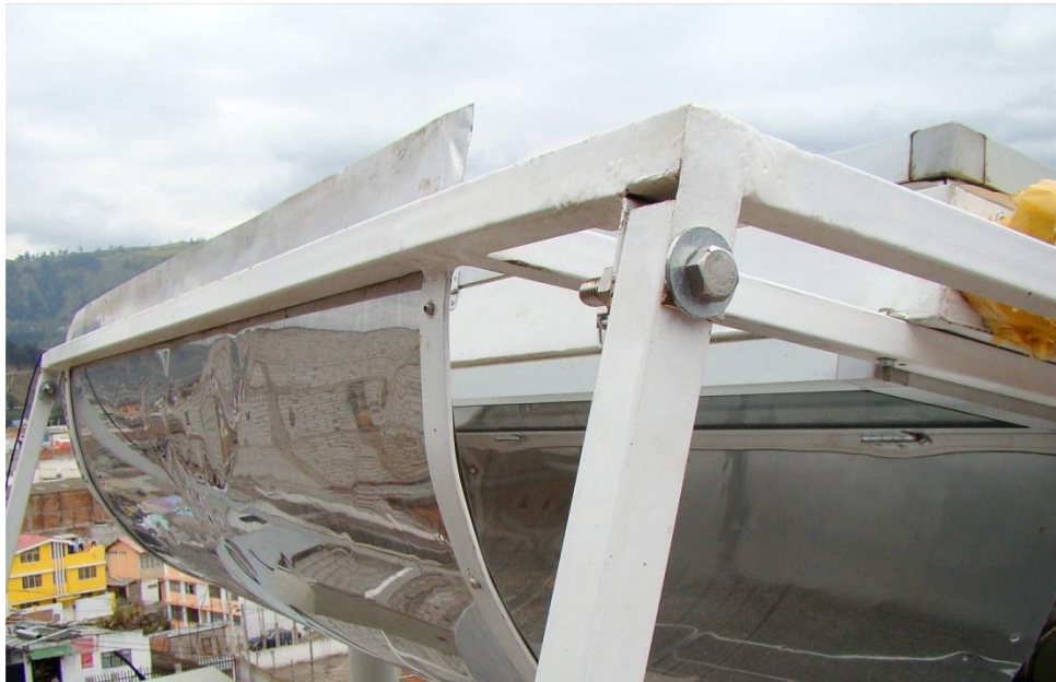
Fotografía 10: Bases de apoyo del soporte superior.
