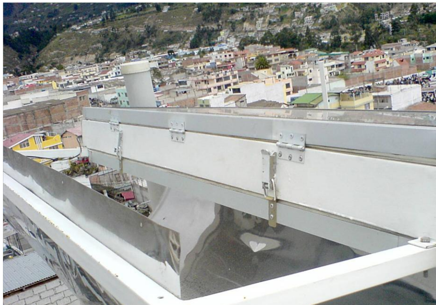
Fotografía 15 : Seguros de sujeción, visagras y empaques para coberturas.
