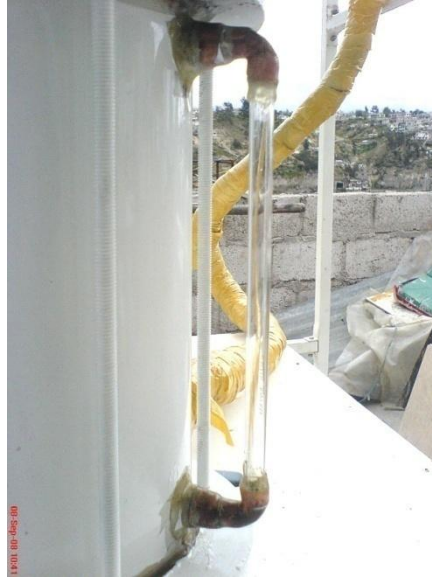
Fotografía 20: Visor acoplado al acumulador de líquido.
