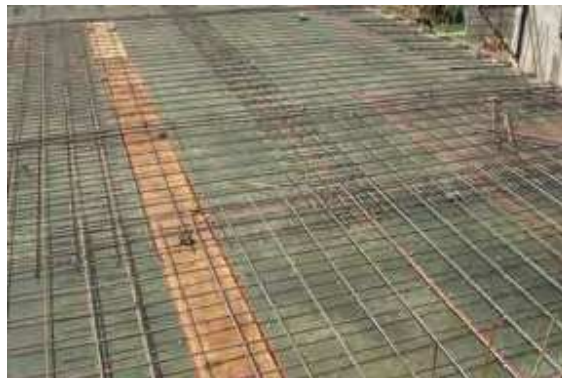
Foto 3-15: Encofrado con paneles contrachapados.
