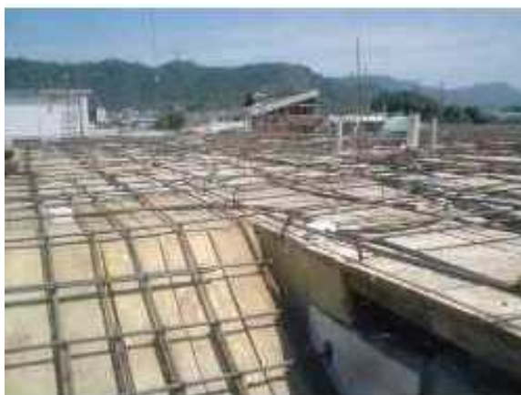
Foto 3-16: Encofrado tradicional.
