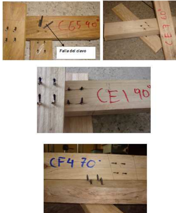
Foto. 5-12. Falla típica de uniones clavadas (se observa que la madera se encuentra intacta y los clavos son los que fallan)
