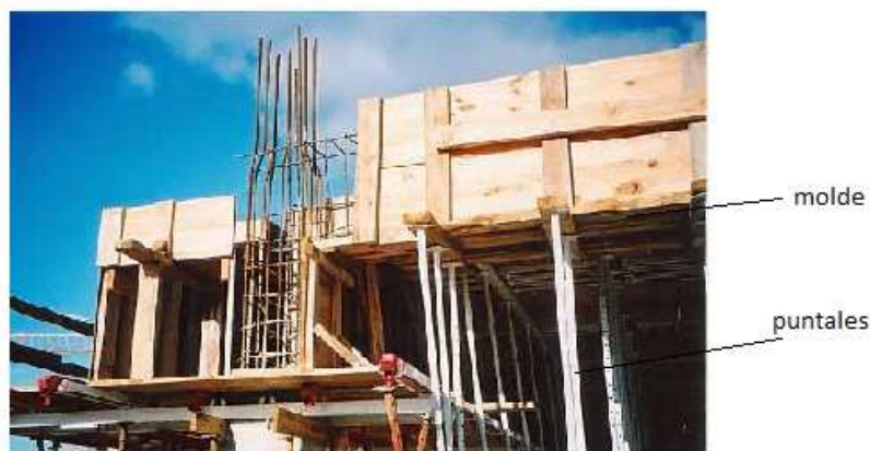
Foto 3-15: Elementos del Encofrado.
