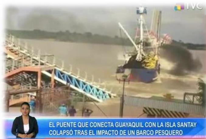
*Imagen 3: Puente que conecta la isla Santay colapsó tras el impacto de un buque pesquero.*
