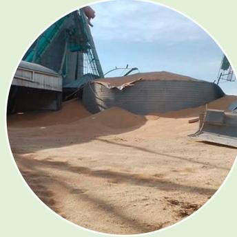
Los daños en la estructura de los silos se producen por factores como son: corrosión en el material de la estructura, grietas por limitada inspección de la estructura, fallos en soldadura y uniones mecánica
