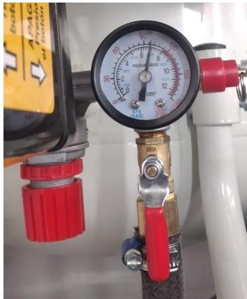
*Nota.* Ajuste de la presión en el compresor, acorde al funcionamiento de la red de aire comprimido del laboratorio de Hidrónica y Neutrónica de la Universidad de las Fuerzas Armadas ESPE-L. Sede Latacunga.
