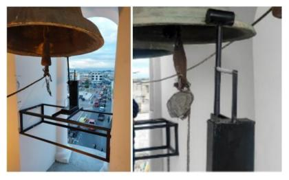
Nota. La figura representa la instalación del sistema electromecánico.
