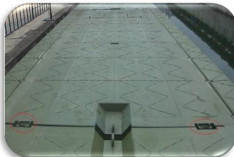
*Nota.* La ilustración de sistema de autobloqueo del tramo de puente. Tomado de (B.E 68 «COTOPAXI», s. f.).
