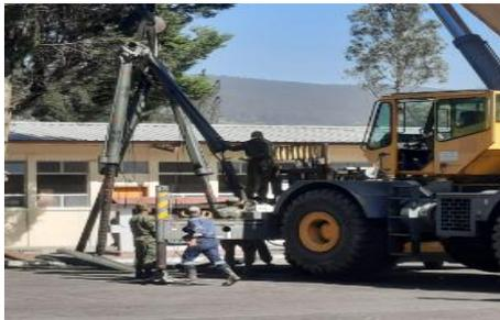
*Nota.* Podemos evidenciar los Bípodes del Puente HZ Tipo Tijera con sus ejes principales.
