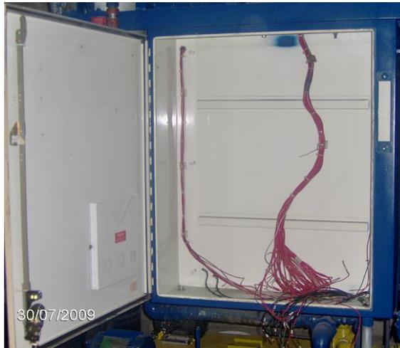
**Figura 5. 41.-** Apariencia de la caja de potencia antes de la instalación del tablero.
