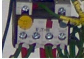
**Figura 4. 13.-** Aspecto externo del relé térmico utilizado en la repotenciación.
