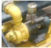
**Figura 2. 16.-** Bomba de engranes internos con cuña, de la línea de Polioli.
