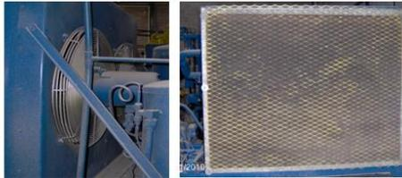
**Figura 3. 7.-** Condensador parte posterior **Figura 3. 8.-** Condensador parte frontal
