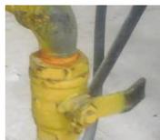
Figura 2. 12.- Válvula tipo bola de la línea de Polioli.
