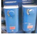
Figura 2. 8.- Termostato de freezestart y de agua fría.
