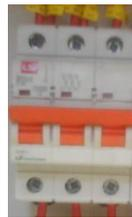
**Figura 4. 11.-** *Aspecto externo de los fusibles utilizados para la repotenciación.*
