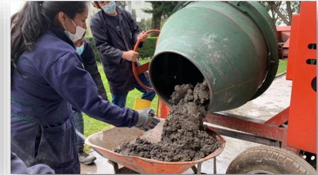
Vaciado de hormigón
