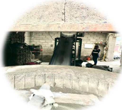
Vaciado de Hormigón
