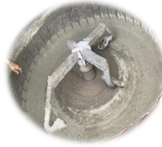
Mezcla del Material
