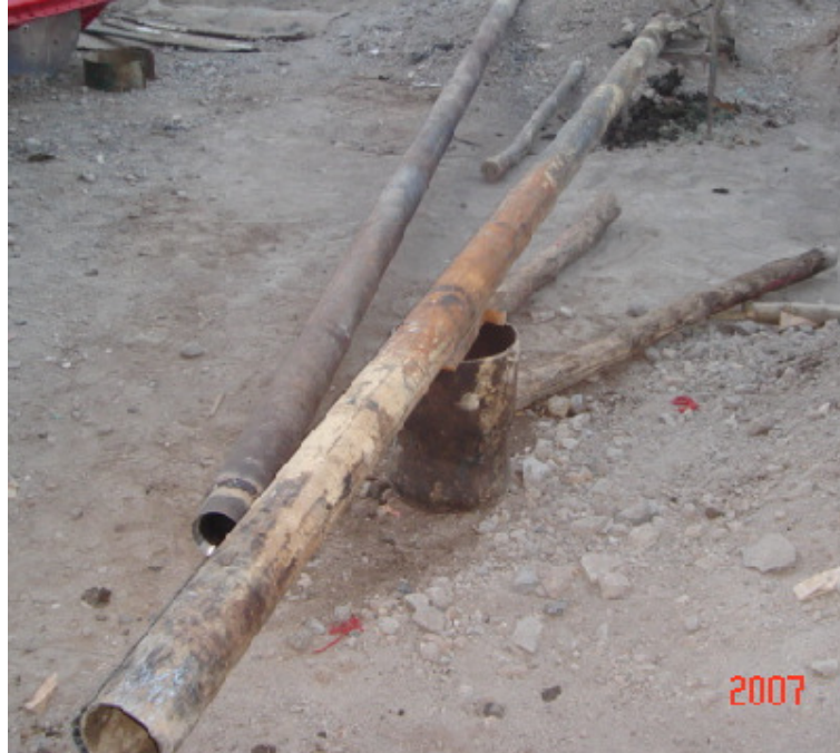
Fig. 5.4 Colocación de acoples espiga tipo campana en la tubería de presión.
