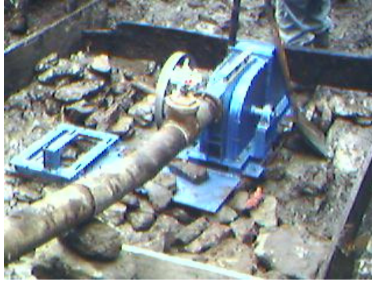
Fig. 5.5 Cimentación de la turbina Michell Banki al piso.
