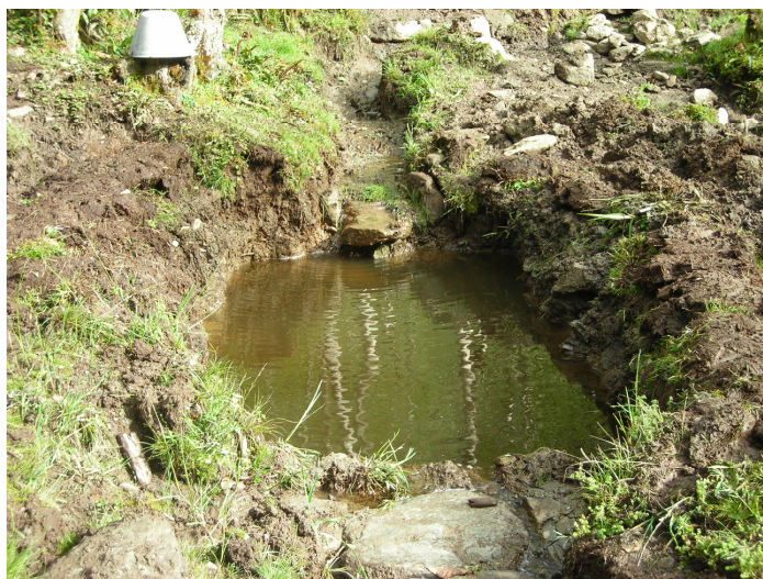
Fig. 5.2 Excavación de desarenador tipo horizontal
