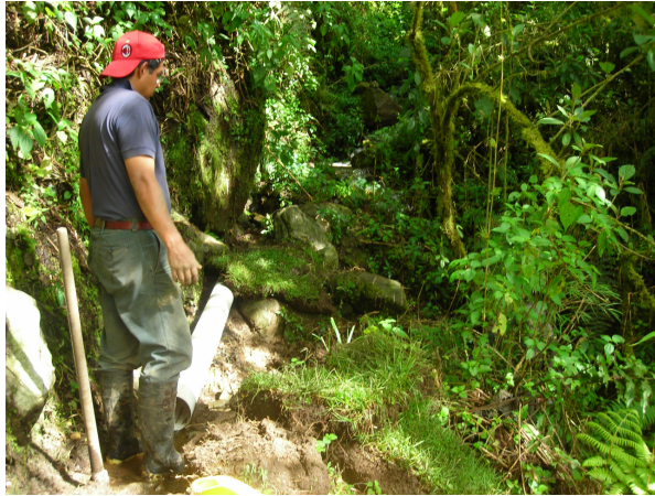
Fig. 5.1 Instalación de la Bocatoma
