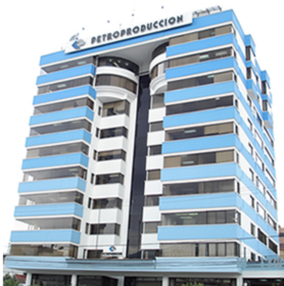
Figura 2. 1. Petroproducción Edificio Villafuerte (Matriz)
