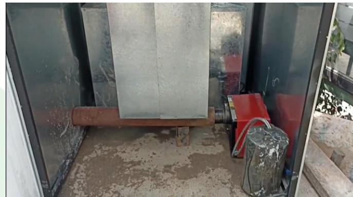
Montaje del Quemador Riello 40F10 y ventilador centrifugo TDA 1515L
