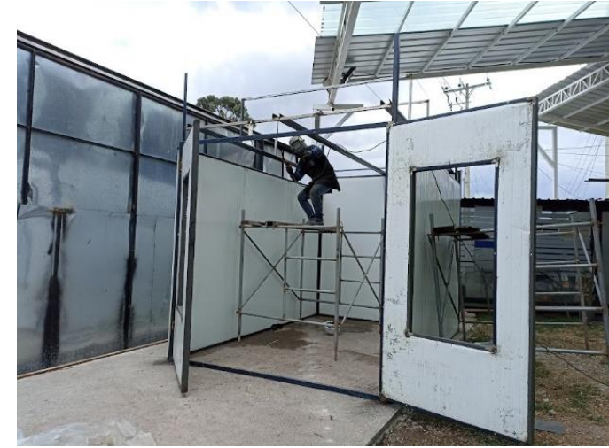
Fijación de la estructura para soporte de paneles de iluminación
