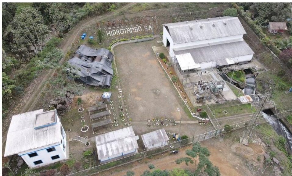
Casa de máquinas
