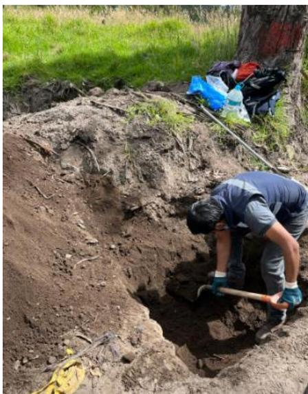
*Nota.* La excavación se realizó a 1.50 m mediante la utilización del EPP y herramientas
