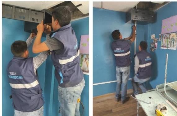
*Nota.* En la figura se puede observar la ubicación del gabinete y la fijación de las canaletas para la protección del cable de energía.
