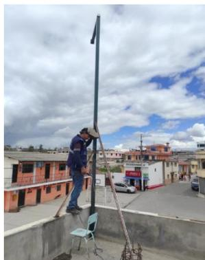
*Nota.* En la figura se muestra el aseguramiento a la terraza del poste metálico para la instalación de la cámara PTZ.
