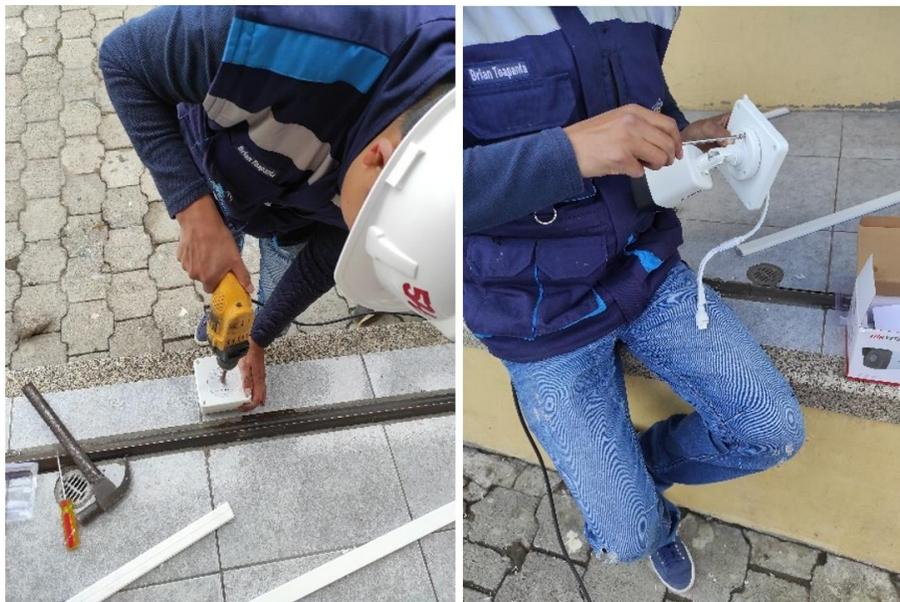
*Nota.* En la figura se puede observar las adecuaciones necesarias se debe realizar para empotrar la cámara en la caja hermética.
