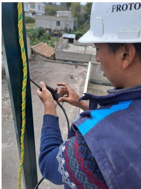
*Nota.* En la figura se puede observar la colocación de una pinza de anclaje para asegurar el cable FTP.
