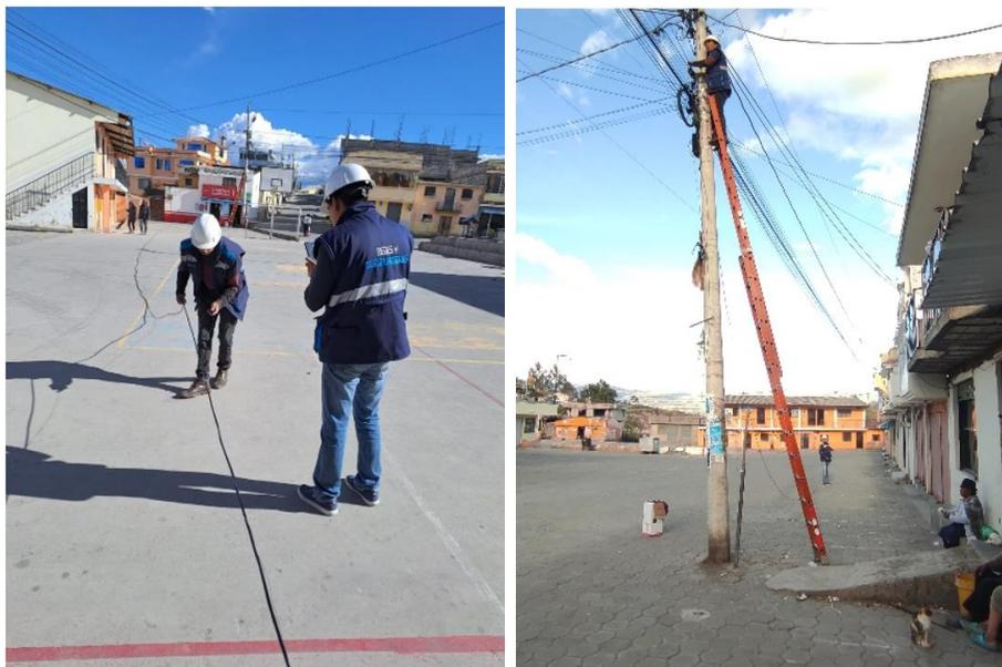
*Nota.* La figura muestra el proceso realizado para el tendido del cable par trenzado en los postes de luz.
