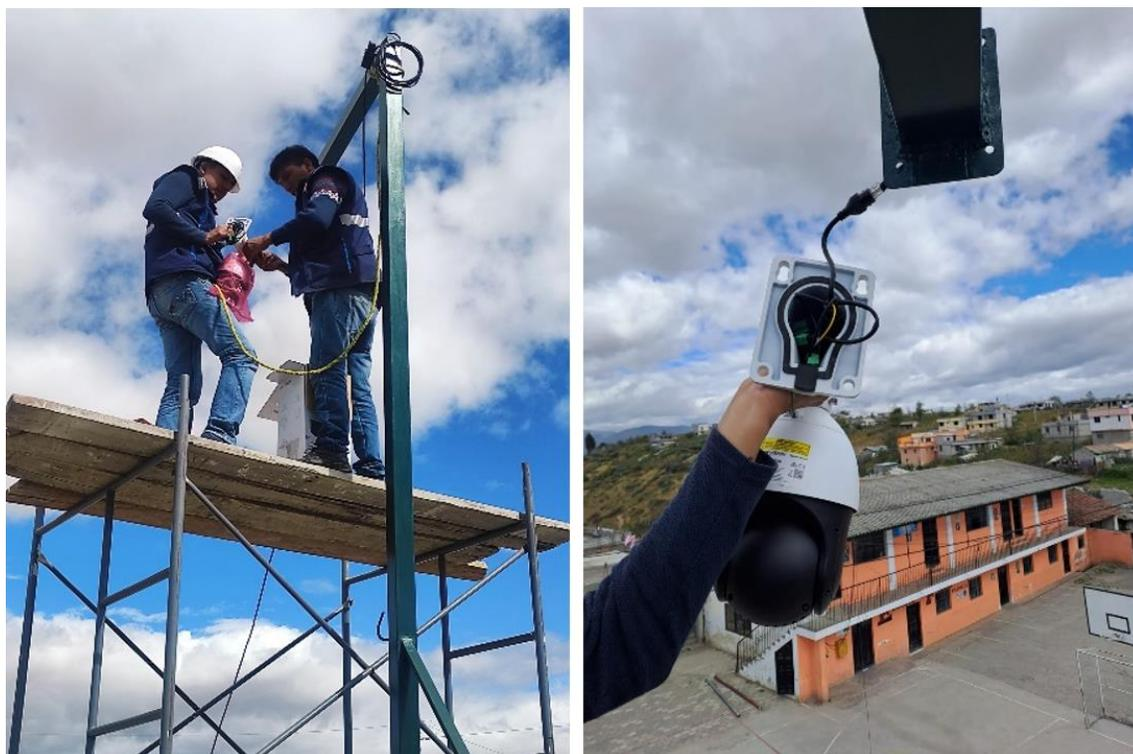
*Nota.* La figura indica el proceso que se llevó a cabo para instalar la cámara PTZ en el poste metálico.
