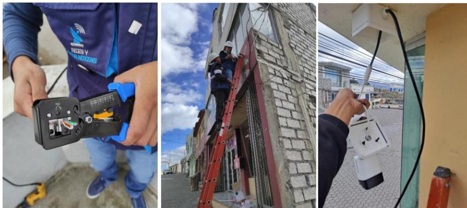
*Nota.* En la figura se puede observar el ponchado del cable, la colocación de la cámara en la panadería y en la casa amarilla.
