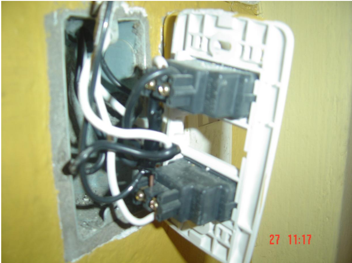
Figura 2.8 Conexión física del control de los interruptores
