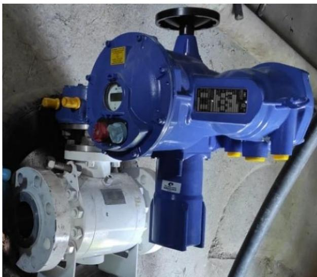
El actuador dispone de un modo de control local mediante botones y remoto por cableado enduro o comunicación. El botón rojo permite seleccionar el control a distancia (remoto), local o deshabilitado (off). El botón de control local (azul) de apertura y cierre permite maniobrar el servomotor en el sentido deseado. La parada local se efectúa mediante una rotación momentánea del botón rojo local/remoto, con los botones se puede realizar la configuración de la válvula.
