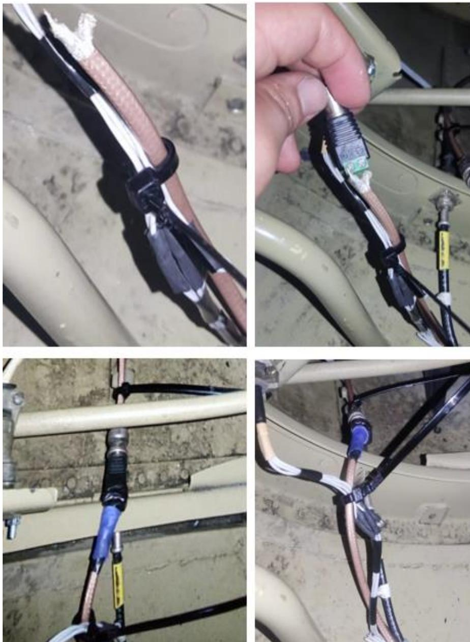
*Nota.* Reparación e instalación del conector coaxial de entrada tipo bnc, se aisló la instalación por medio de un tubo termo encogible.
