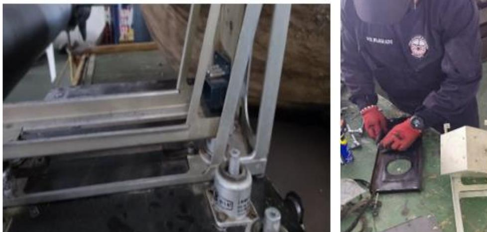
*Nota.* Limpieza de los soportes empleando el disolvente MEK.
