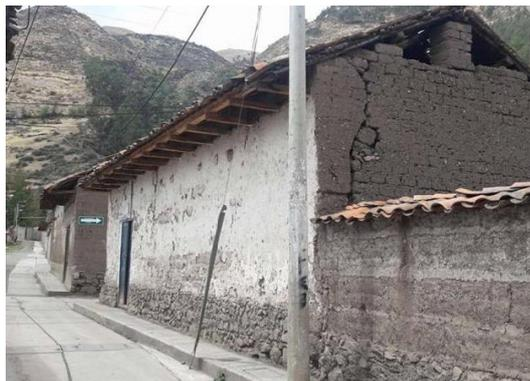
*Nota.* La imagen muestra una construcción con alto grado de vulnerabilidad a eventos sísmicos debido al diseño y materiales de construcción. Toma de Evaluación de vulnerabilidad sísmica de las edificaciones de la zona urbana del distrito de Chiquián, utilizando el model builder de ArcGis, por (Tinoco Meyhuay, Cotos Vera, & Bayona Antúñez, 2018) Universidad Nacional Santiago Antuñez de Mayolo.
