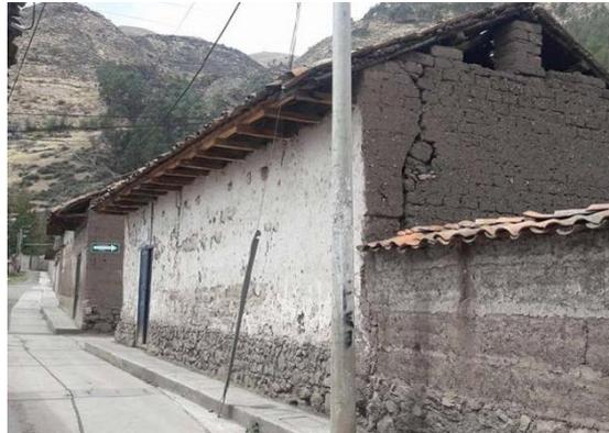
*Nota.* La imagen muestra una construcción con alto grado de vulnerabilidad a eventos sísmicos debido al diseño y materiales de construcción. Tomado de *Evaluación de la vulnerabilidad sísmica de las edificaciones de la zona urbana del distrito de Chiquián, utilizando el model builder del ArcGIS*, por (Tinoco Meyhuay, Cotos Vera, & Bayona Antúnez, 2018), Universidad Nacional Santiago Antúnez de Mayolo.
