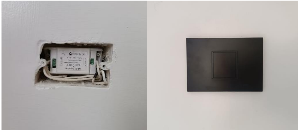
Fig. 25. Instalación de Switch on y off simple Wi-Fi
