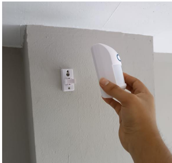
Fig. 31. Instalación del sensor antimascotas en el garaje
