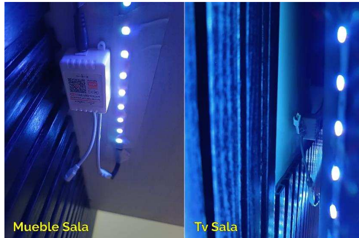
Fig. 28. Instalación de Controladores Wi-Fi RGB
