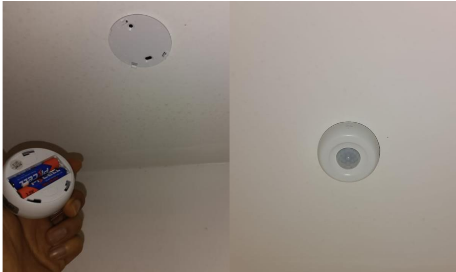
Fig. 30. Instalación de sensor PIR 360°
