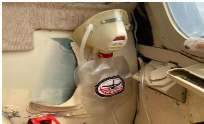
Instalación de las máscaras de oxígeno de tripulación
