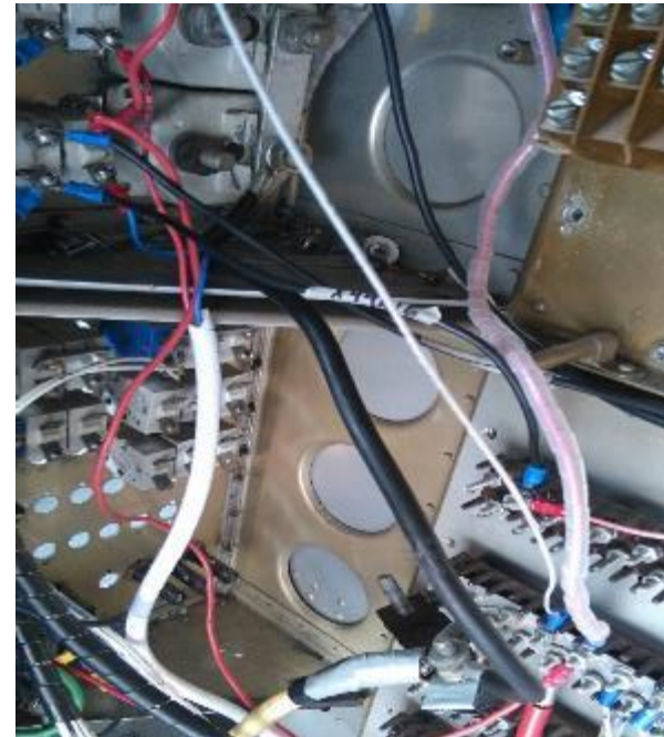
Conexión relés y barra DC
