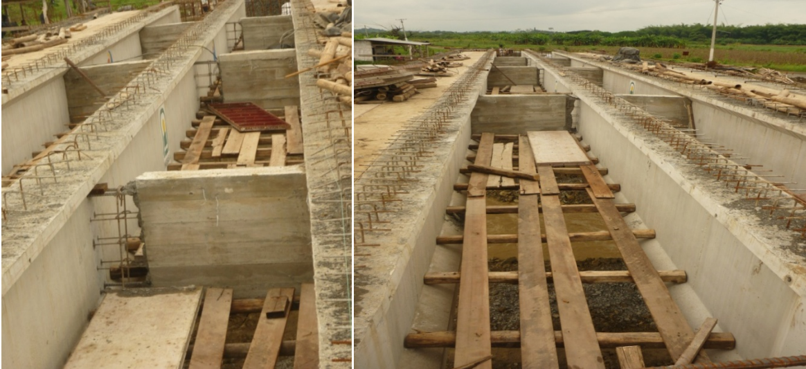
Figura 2-27 Vigas transversales y longitudinales
