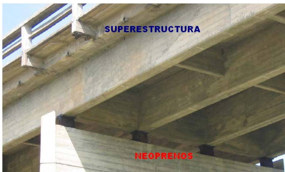
Figura 2-10 COLOCACION DE APOYOS DE NEOPRENOS EN UN PUENTE
