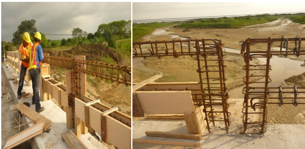
Figura 2-28 Protecciones laterales del puente
