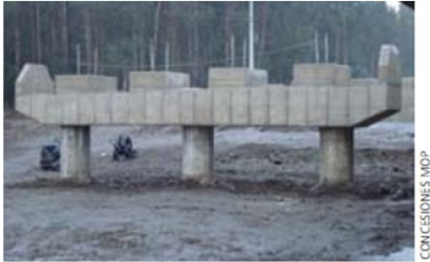
Figura 5-142 Ejemplo Topes sísmicos y travesaño (fuente Paola Chapple revista bit)
