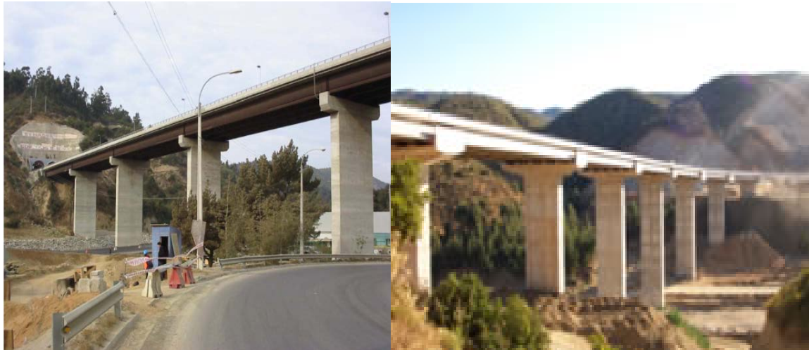
Figura 2-41 Puente Marga-Marga Chile
