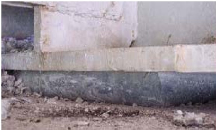
Figura 2-14 Neopreno con deformación (Ing. Jáuregui 2007)
