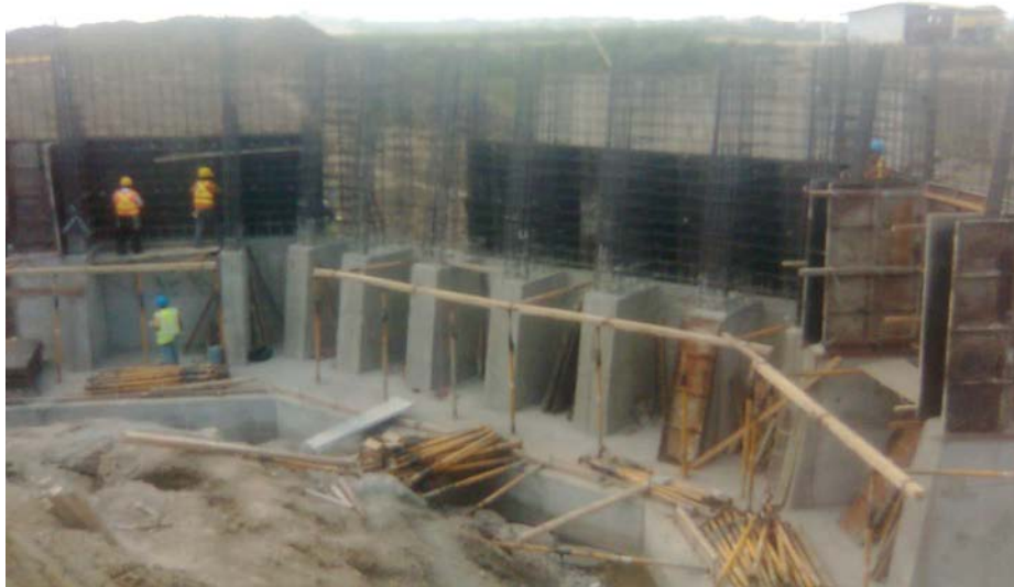
Figura 2-26 Estribos con contrafuertes
