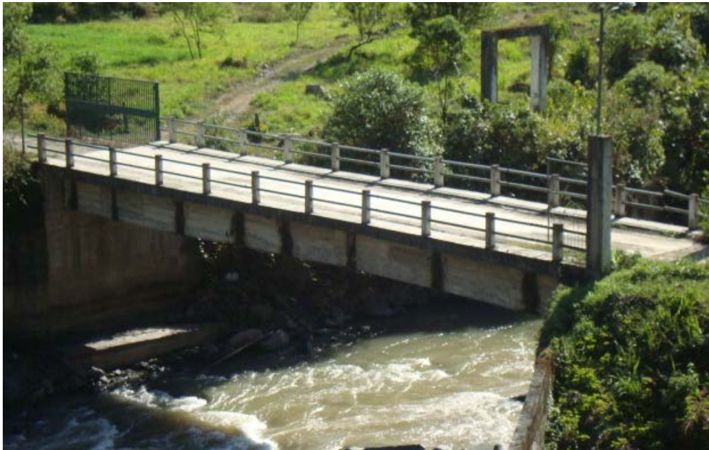
Figura 2-12 Puente con vigas de hormigón
