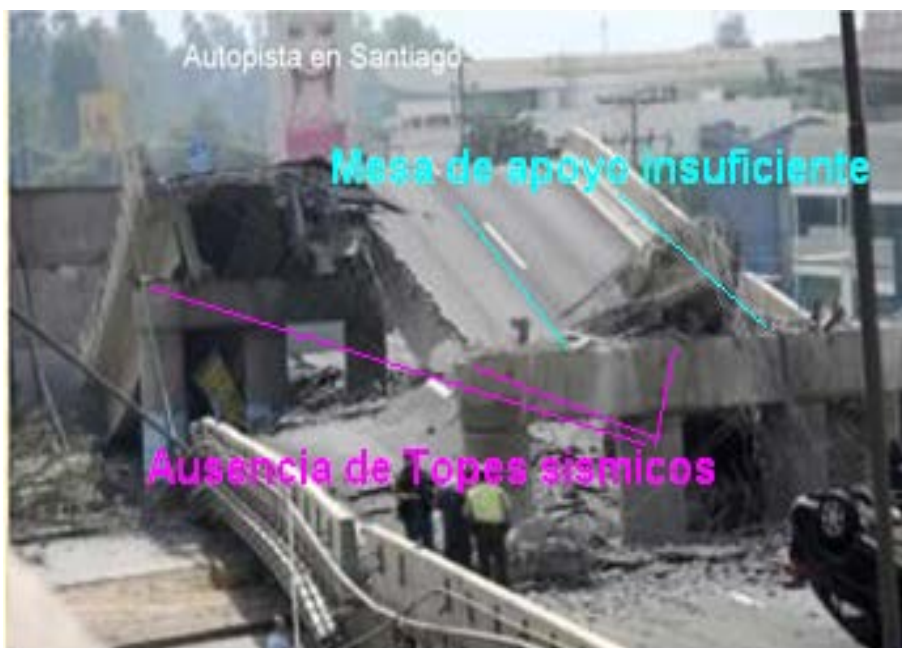
Figura 2-31 Puente en la Autopista de Santiago (Fuente Cámara Chilena)
