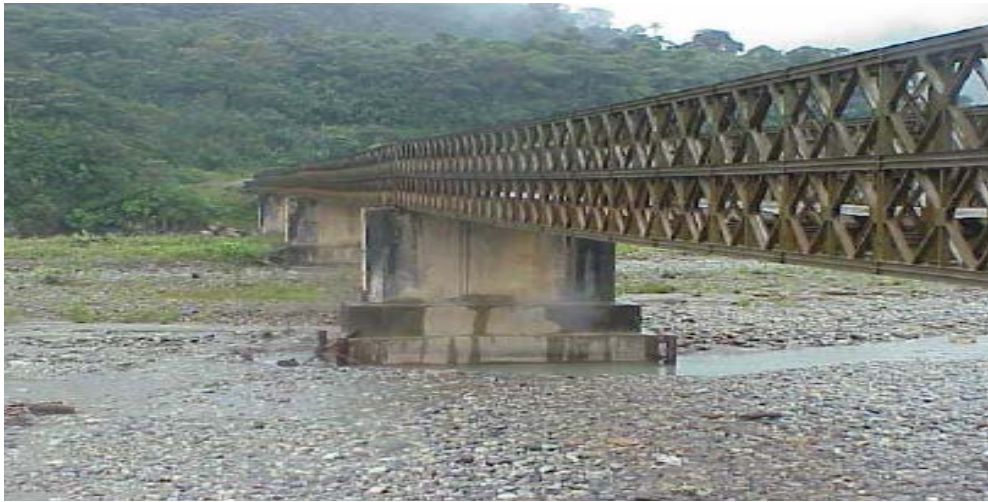
Figura 2-11 Puente con vigas de acero
