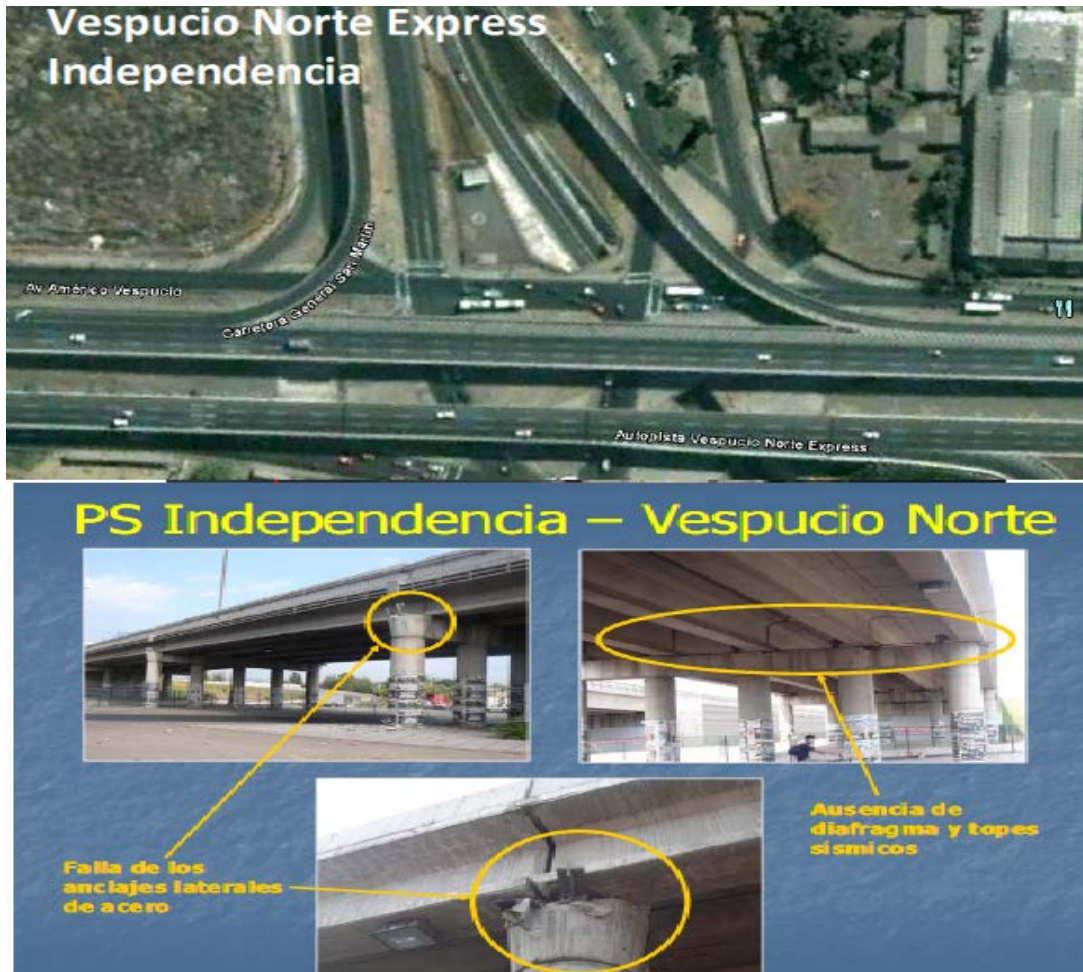
Figura 2-36 Puente Vespucio Norte (Fuente Santa María y Carlos Córdova 2010)
