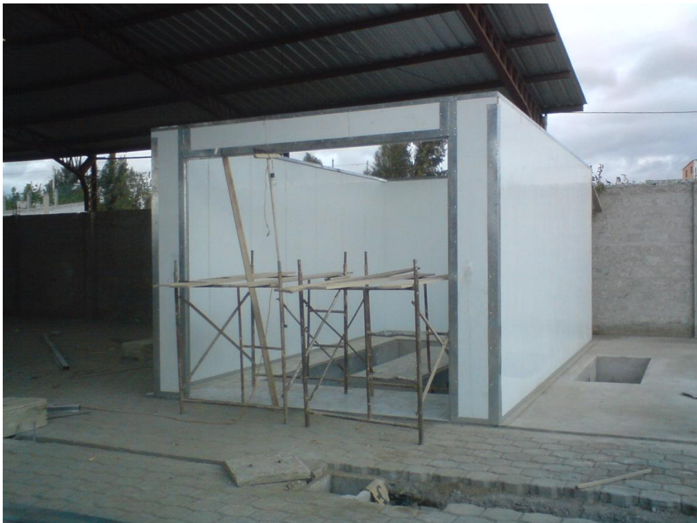
Fig. 5.14 Paneles térmicos formando ya la estructura completa de lo que será nuestra cabina de pintura, con sus refuerzos laterales los cuales fijan las paredes de lado y lado.
