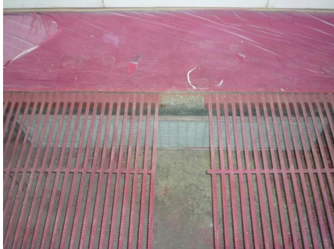
fig. 6.1 2. Área de salida de gases.
