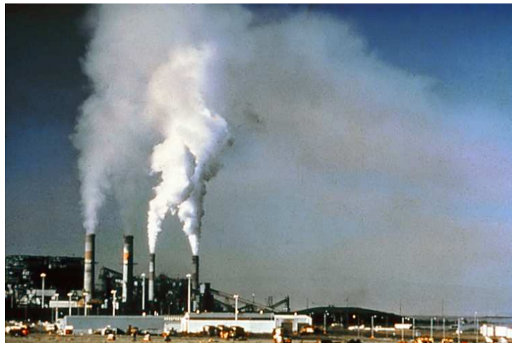
Figura. 2.7. Planta generadora que libera dióxido de azufre y otros contaminantes del aire.
