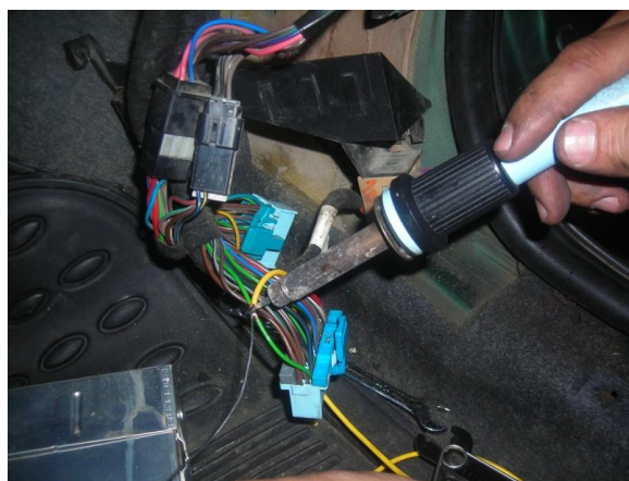
Figura 4.7: Cable de conexión
