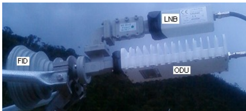
Figura 2.3 Unidad exterior de la antena satelital
