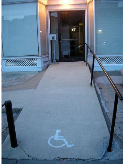
Figura 1.1 Rampa de acceso
