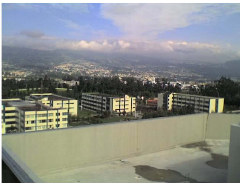
Vista lateral derecha desde el Edificio Nuevo
