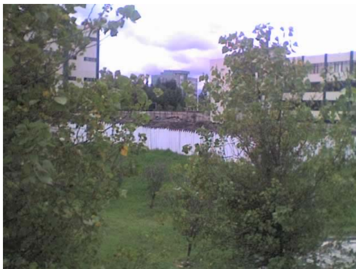
DEE - Edificio Administrativo
