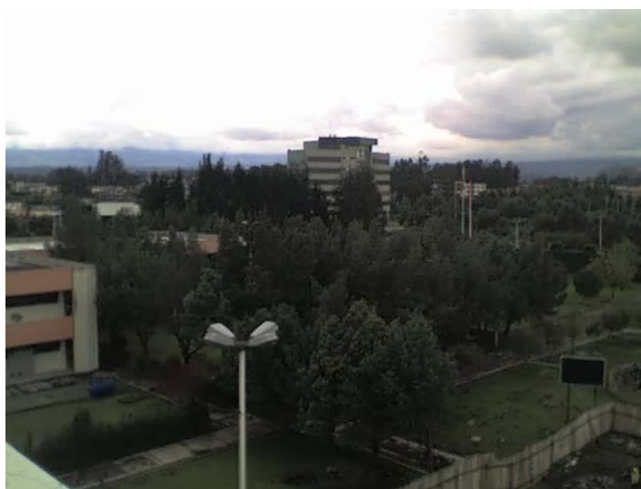
Bloque D-Edificio Administrativo
