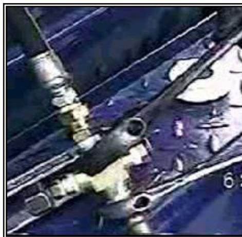
**FIGURA 5.36 AJUSTE DE CRUZ DE CONEXIÓN**
