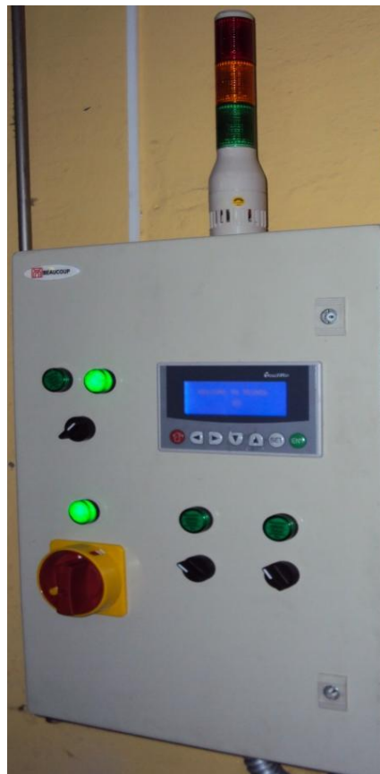
Figura 1: elementos externos del tablero
