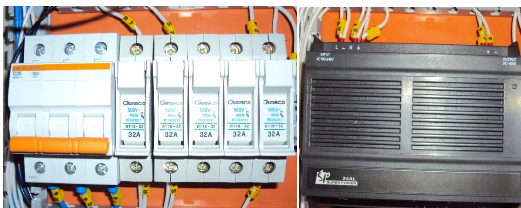
Figura 65: Elementos de protección y fuente externa
