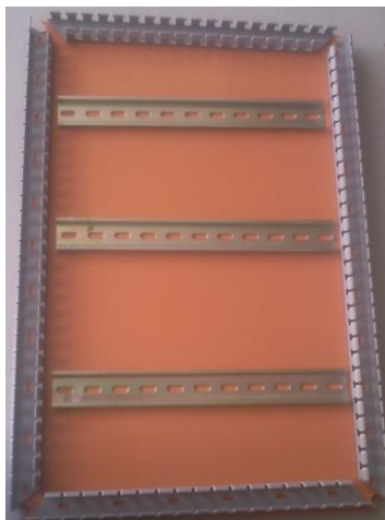
Figura 64: Colocación de la riel DIN
