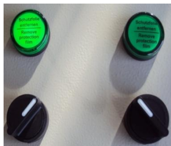
Figura 12: funcionamiento de bomba 1 modo automático
