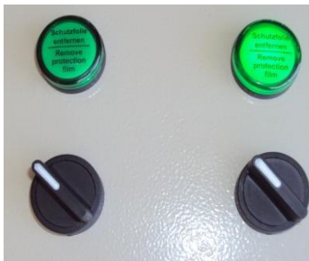
Figura 11: funcionamiento de bomba 2 modo automático
