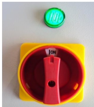
Figura 3: selector en ON
