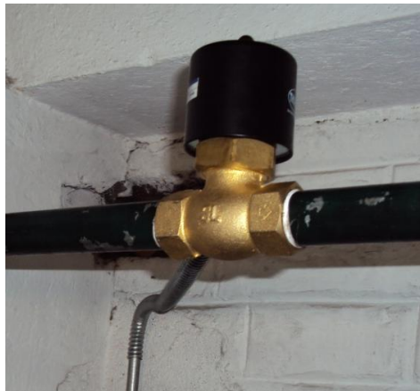
Figura 67: Electroválvula para agua fría
