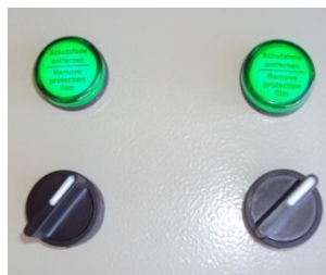
Figura 8: selectores en ON modo manual
