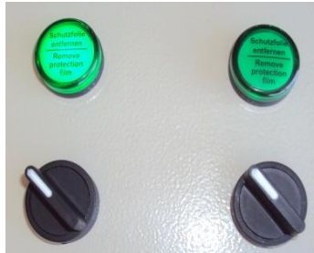
Figura 10: funcionamiento de bomba 1 modo automático
